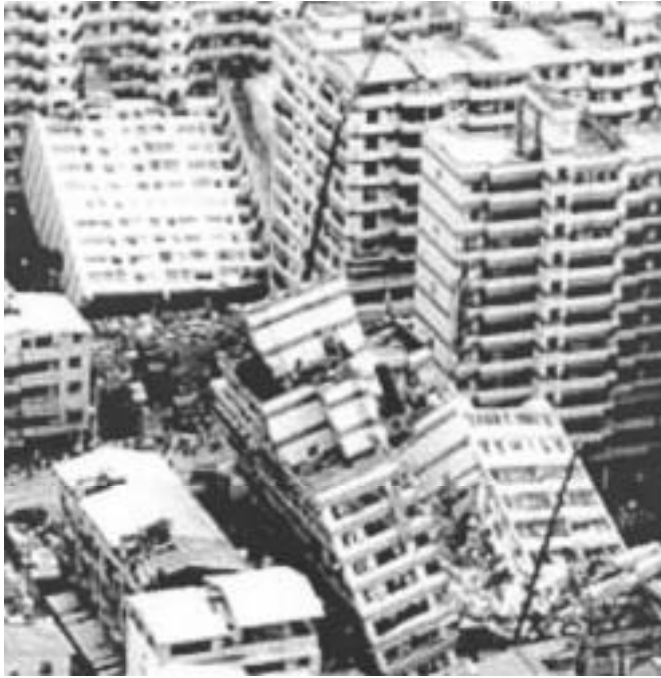
地震災害可能造成大樓倒塌的危險
