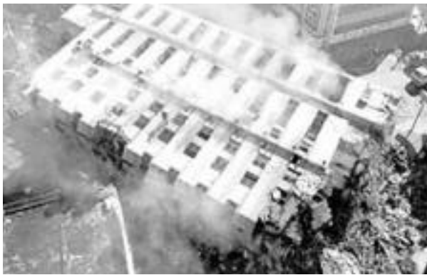
房屋倒塌情形下
